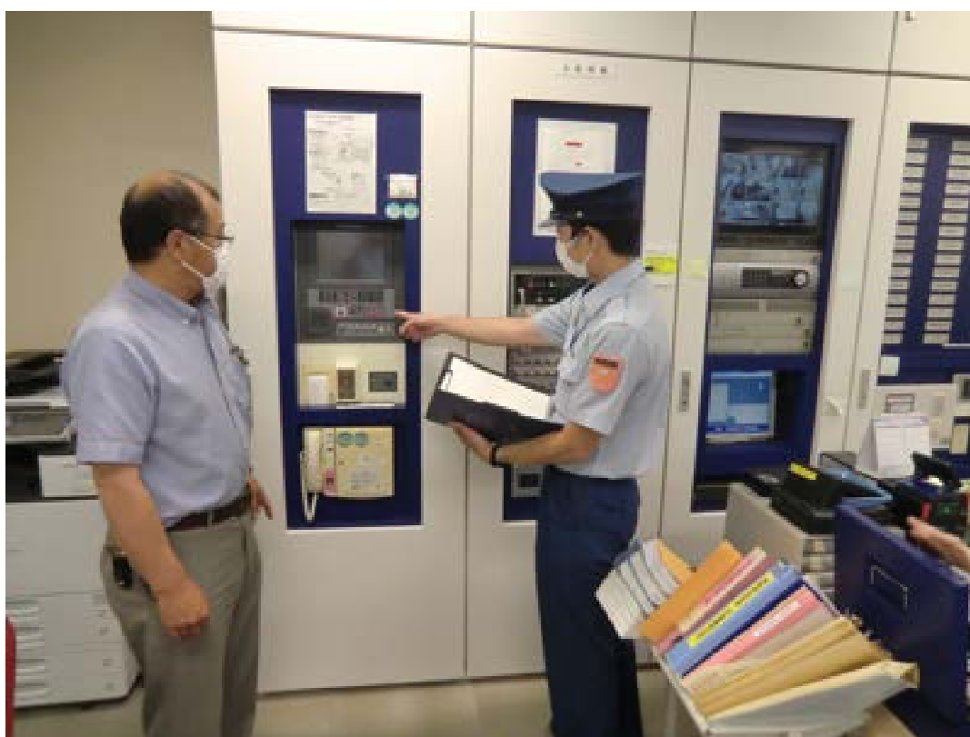
( 消防用設備等の検査 )
