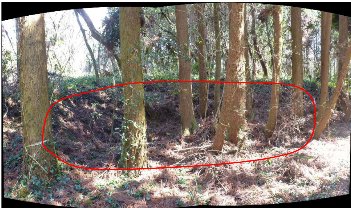
写真 5.8.2 ドリーネと思われる陥没地形
