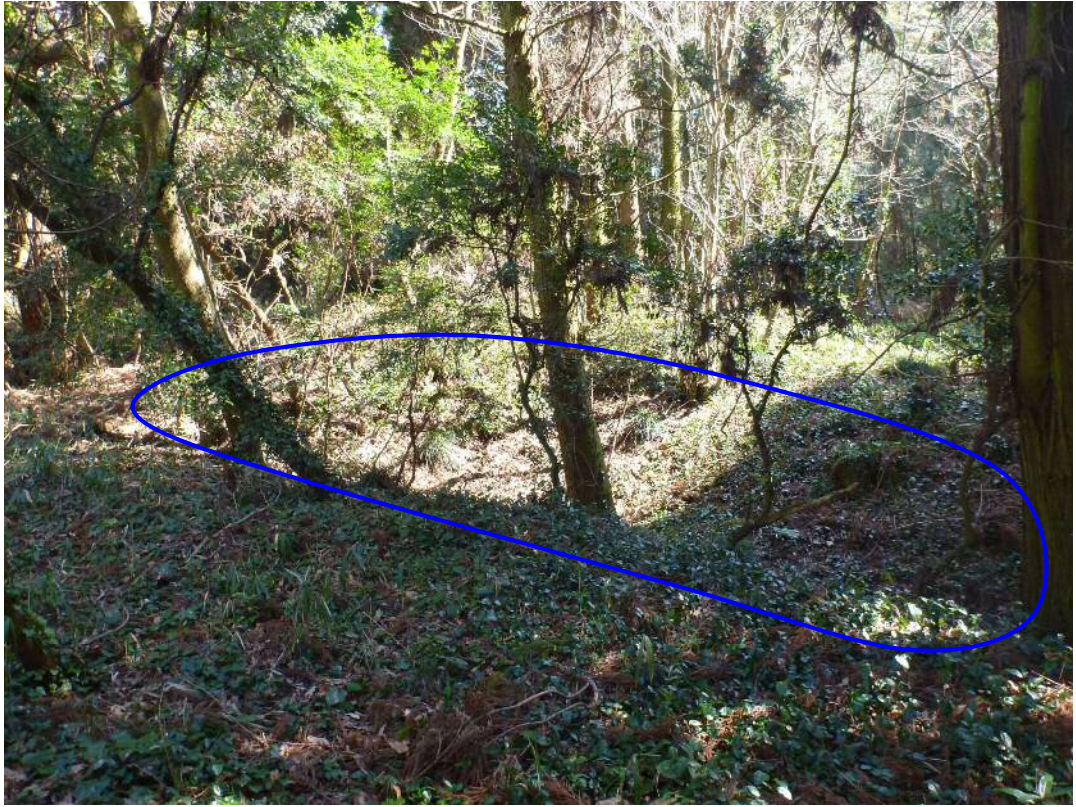
写真 5.8.6 ドリーネの存在が疑われる陥没地形
