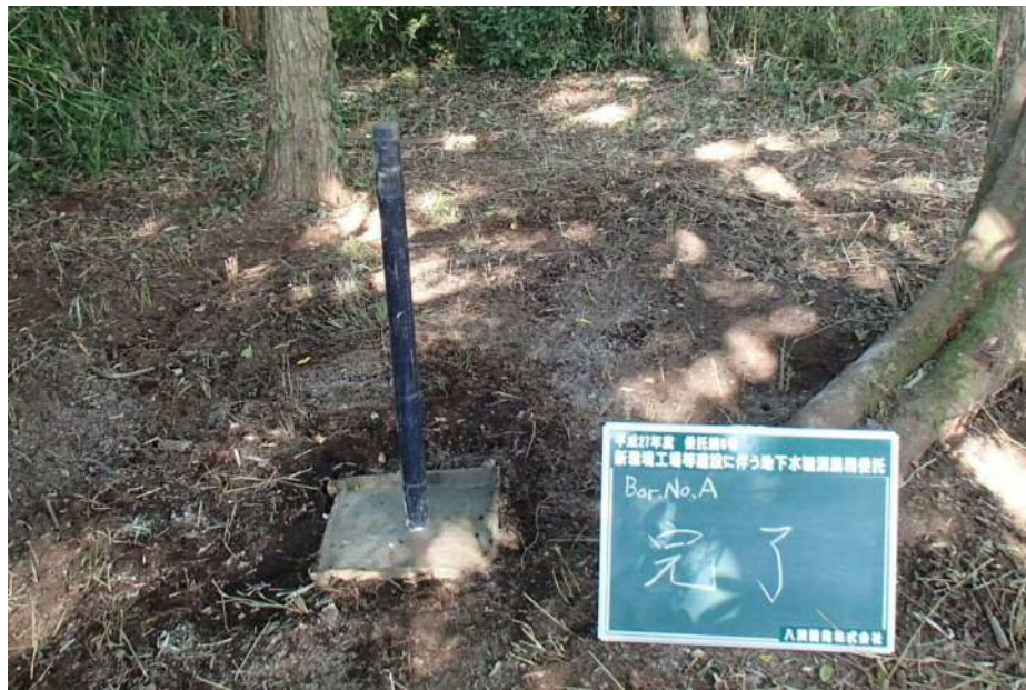
写真-2 コンクリート孔口保護の状況
