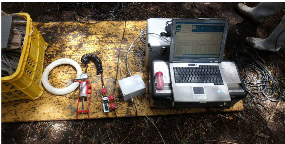
写真-1 パソコン設置状況
