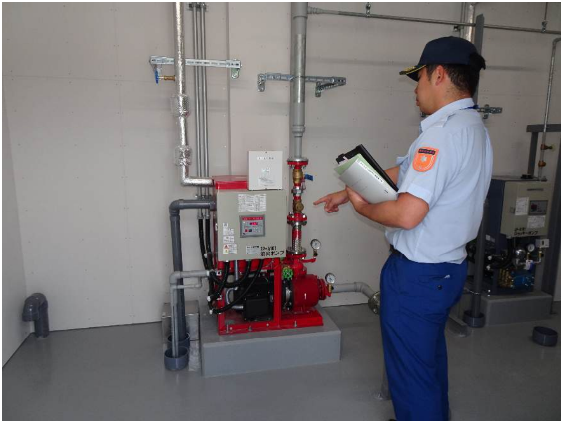
( 消防用設備等の検査 )
